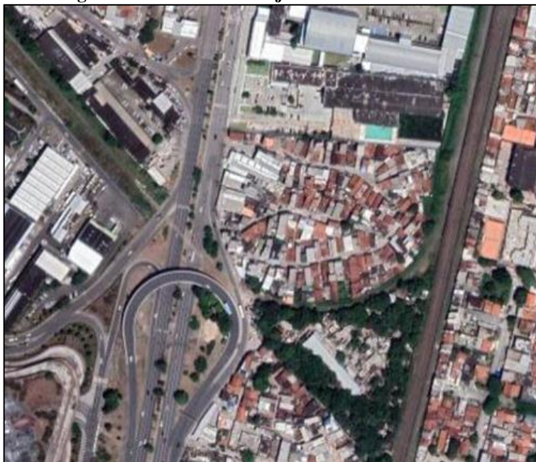
Figura 1 – Território de Tijolos e entorno em satélite
